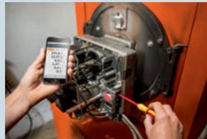
**Solution :** mesurer les pertes par les fumées et les valeurs des émissions (CO, CO<sub>2</sub>) et constater le cas échéant la nécessité de réaliser les travaux de maintenance.
