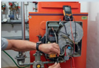
**Solution :** contrôle du courant d'ionisation avec un multimètre certifié.
