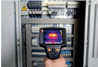
**Solution :** maintenance électrique avec une caméra thermique.
