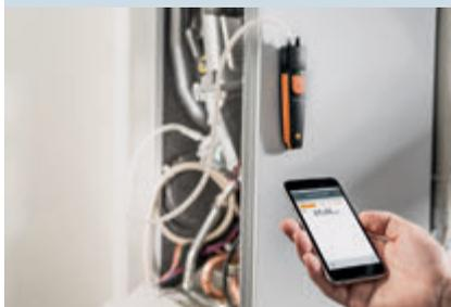
**Solution :** mesure et réglage des pressions correctes.
