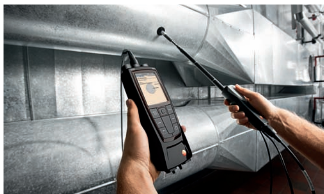
На зонды для измерения скорости потока нанесена шкала, которая облегчает определение глубины погружения зонда в воздуховод
