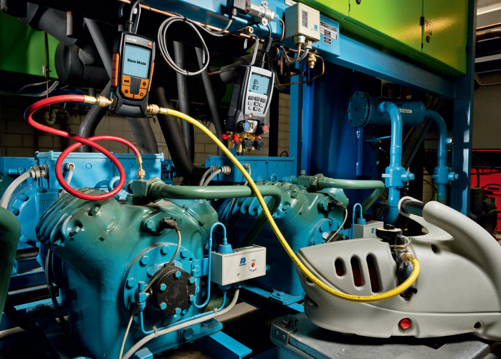
Um Messdaten zu speichern, auszudrucken oder elektronisch zu dokumentieren, kann das testo 552 mit einem Verbindungskabel an das testo 570 angeschlossen werden. Für Langzeitmessungen ist dies problemlos auch über mehrere Tage möglich.
