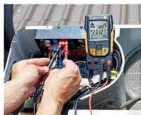
使用testo 760测量空调室外机电压
