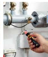
使用testo 745测量配电箱电压
