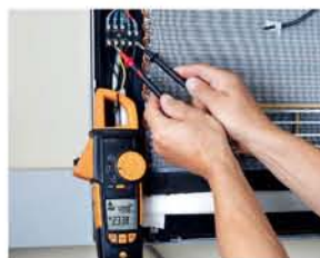
使用testo 770测量空调电压
